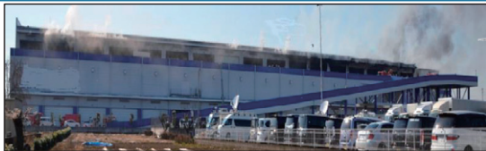
大規模倉庫火災現場
