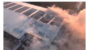
ドローンによる俯瞰撮影により燃焼状態を把握
